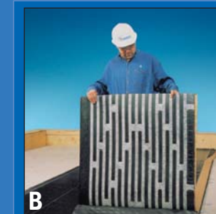
B Détacher une extrémité du film de protection et coller cette partie de la membrane sur l'isolant.
