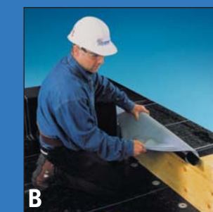
B Installer la membrane de sous-couche des relevés de façon à couvrir complètement les fixations et la surface.
