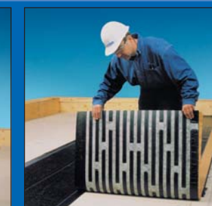
B Détacher une extrémité du film de protection et coller cette partie de la membrane sur l'isolant.
