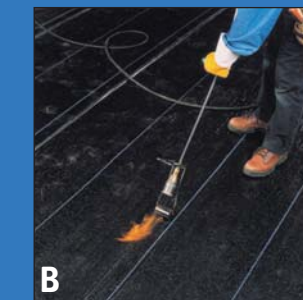
B Sceller les joints transversaux au chalumeau, puis presser la surface à l'aide d'un dégranulateur.
