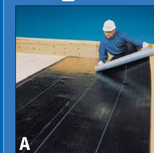
A Aligner la membrane avant de retirer le film de protection détachable.
